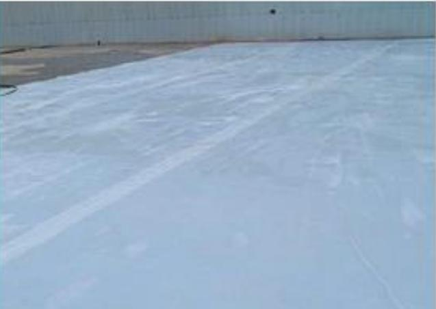
**b) Membranas y plásticos:** En este caso se coloca la membrana de curado por aspersión inmediatamente de concluido el acabado y posteriormente se coloca el plástico. Generalmente se emplea en época de frío para reforzar el proceso del curado. Esta combinación no se emplea cuando el acabado es pulido.
