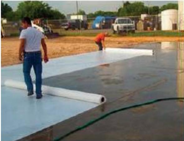
**a) Plásticos y agua:** El plástico se coloca cuando el concreto aun no fragua, una vez endurecido se refuerza con la aplicación de agua por anegación entre la superficie del concreto y el plástico. Cuando la estructura requiere un proceso de acabado, la colocación del plástico evita que el viento provoque grietas, es común en climas fríos cuando el acabado es pulido.
